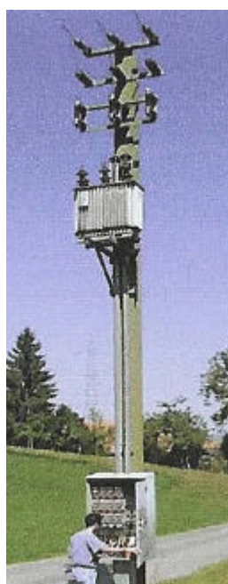
Mât HEB avec transfo 16kV
