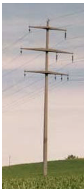
Mât béton 16 et 60kV
