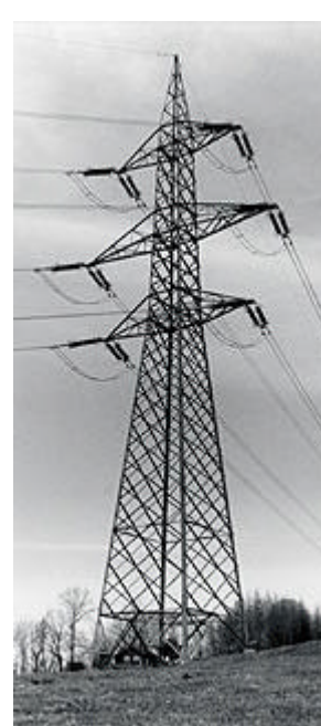
Pylône 60kV et plus
