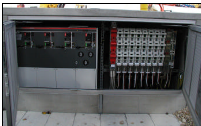
Eléments MT Eléments BT Ici le transfo se trouve derrière la MT (mi-enterré)
